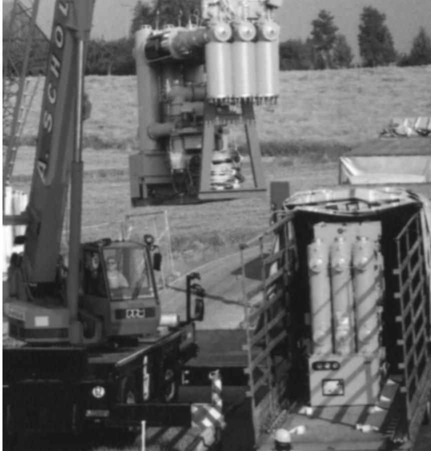
*Descarga en obra de un campo de 170 kV.*
